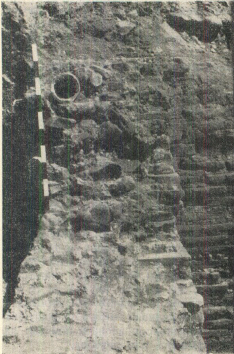
Обр. 3. Водопровод от незашитени глинени тръби, открит при строежа на сграда на Коретом, ул. „Цар Калоян“
